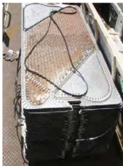
沃肯(Vulcan)安装9个月后：将板式换热器拆开清洗
