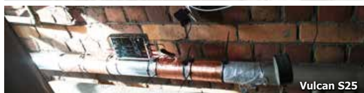
另外两组S25安装在两套供暖系统管路上
