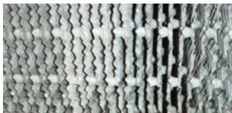
在安装沃肯(Vulcan)之前: 冷却塔的內部
