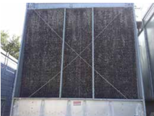
上面CT-1的照片拍摄于沃肯 (Vulcan) 安装三周后(2013年8月6日)。
