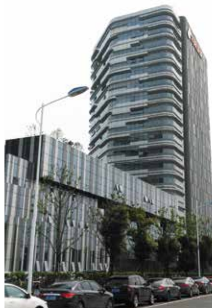
位于苏州的同程网总部大楼
