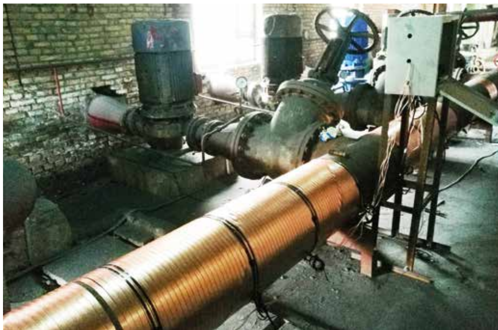
Vulcan S500 解决循环冷却水系统结垢严重的问题
