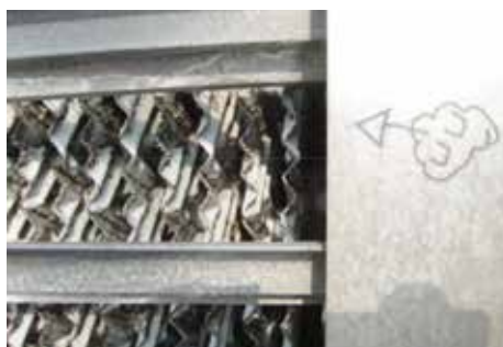
在安装沃肯(Vulcan)之前: 冷却塔外部
