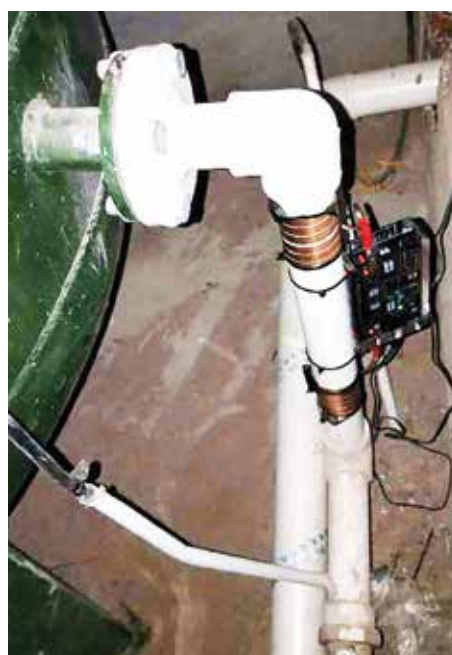
Vulcan 5000安装在洗浴中心压力罐总出水口处
