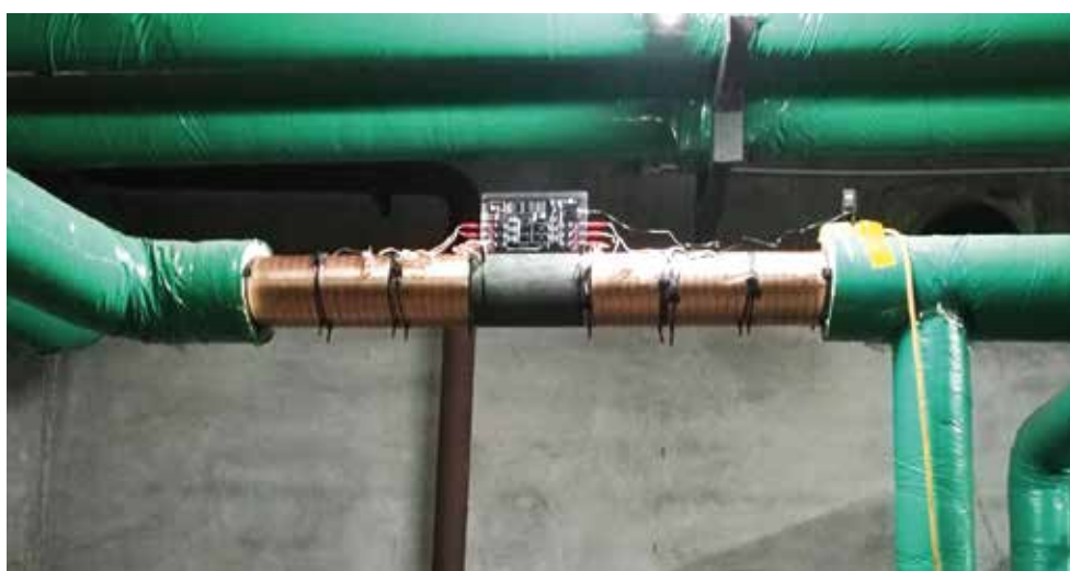
Vulcan S100安装于换热站内低温热水的循环管网主管道上，其补水水源为市政自来水
