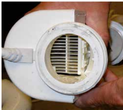
沃肯 (Vulcan) 装置安装30天后, 正在运转的泳池氯化器
