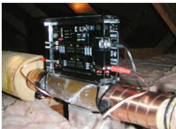
Vulcan S10 安装在 Bodega海边住宅宿舍主管
