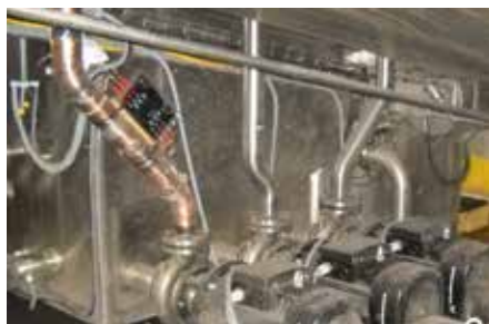
安装在产品清洗系统上的Vulcan S100装置
