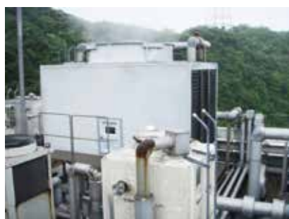
药厂冷却塔屋顶
