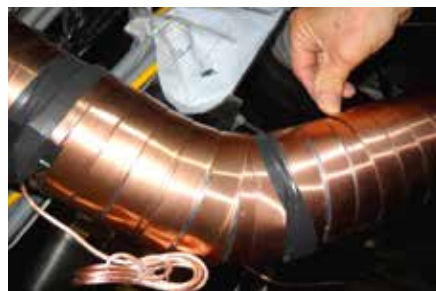
在水管上缠绕了两层的沃肯(Vulcan)脉冲电缆
