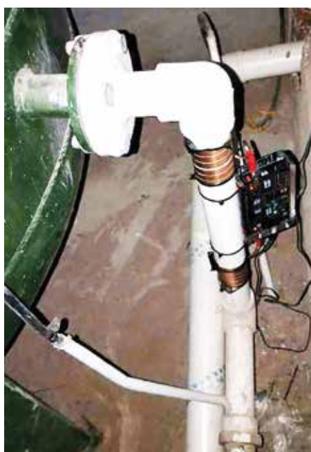
Vulcan 5000安装在洗浴中心压力罐总出水口处
